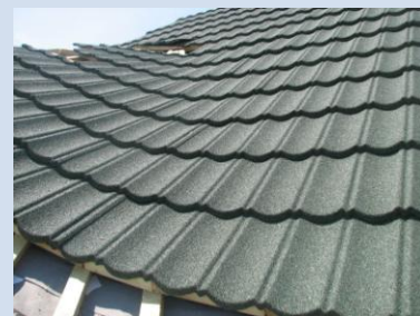
Oceleové krytiny si vďaka ohybnosti poradia s každým typom aj členitých a oblúkových striech
